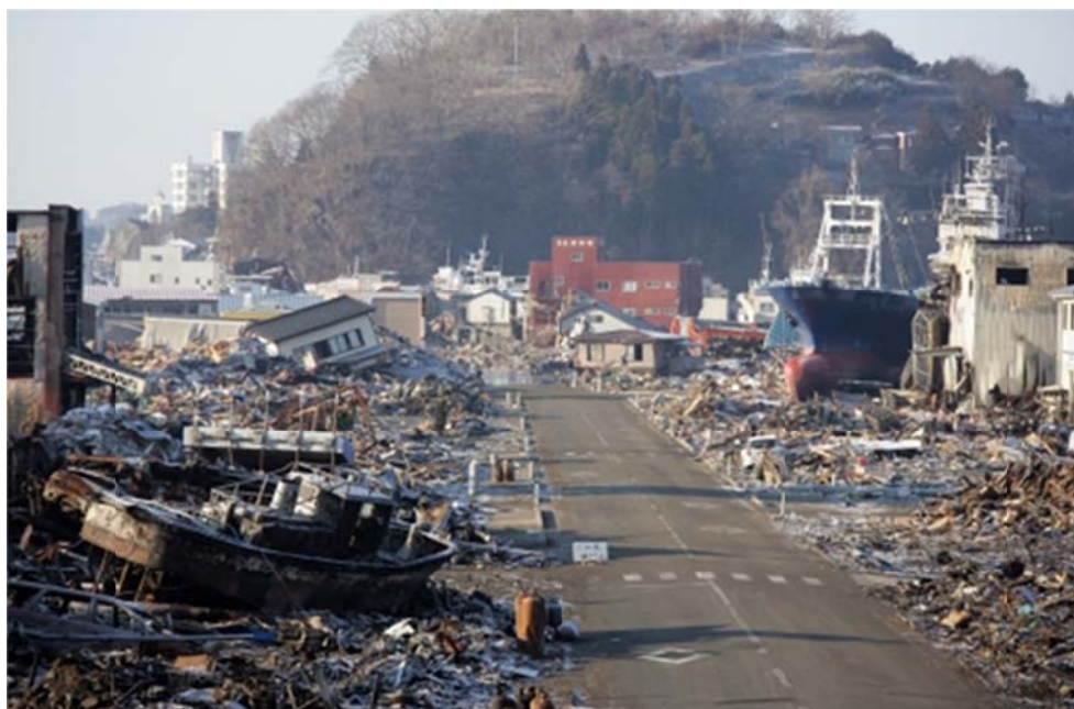
東日本大震災 被災状況
